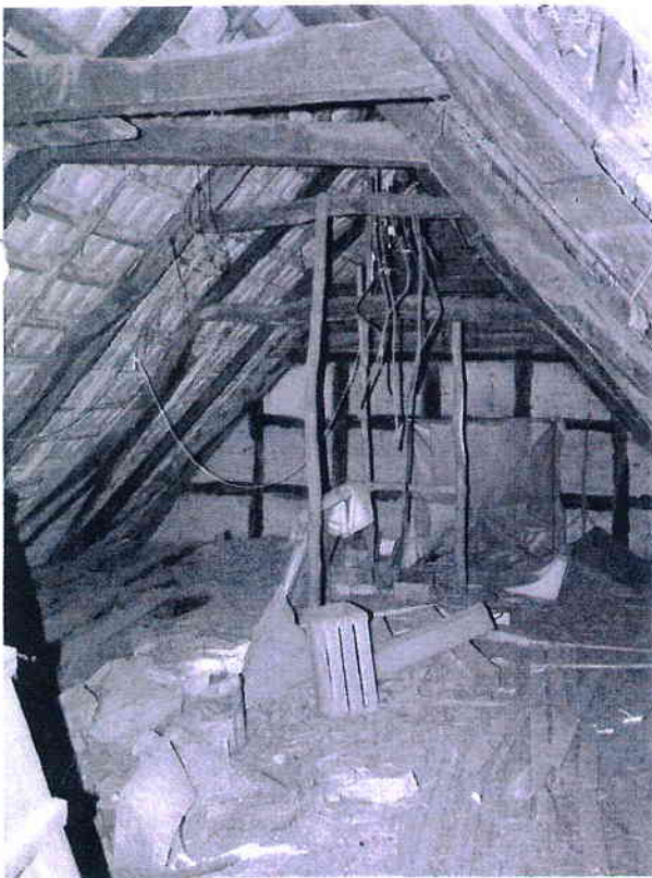
Spitzboden, Nord Betondachsteine, Süd: Hohlziegel in Strohdocken
