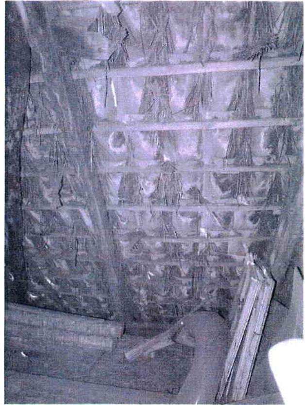
Spitzboden, Nord Betondachsteine, Süd: Hohlziegel in Strohdocken
