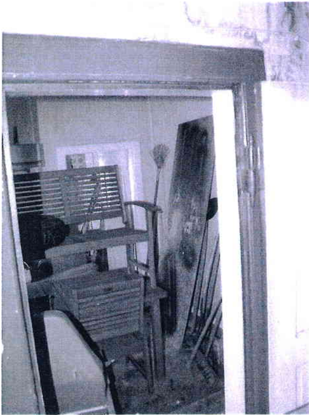
Haupthaus Rübhelhauk 4 in 49626 Berge: ehemalige Wohn-und Schlafräume
