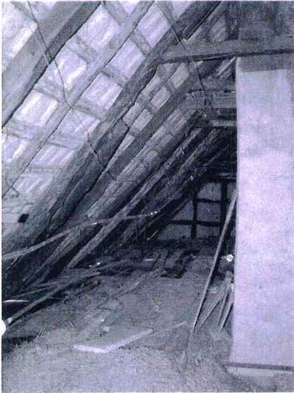
Spitzboden, Nord Betondachsteine, Süd: Hohlziegel in Strohdocken
