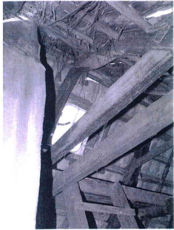
Spitzboden, Nord Betondachsteine, Süd: Hohlziegel in Strohdocken
