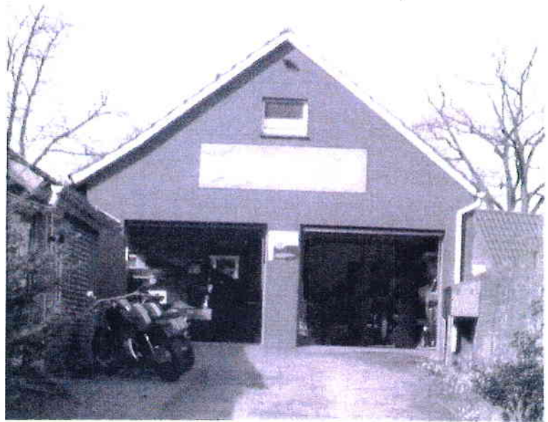
Doppelgarage, Ansicht von Süden
