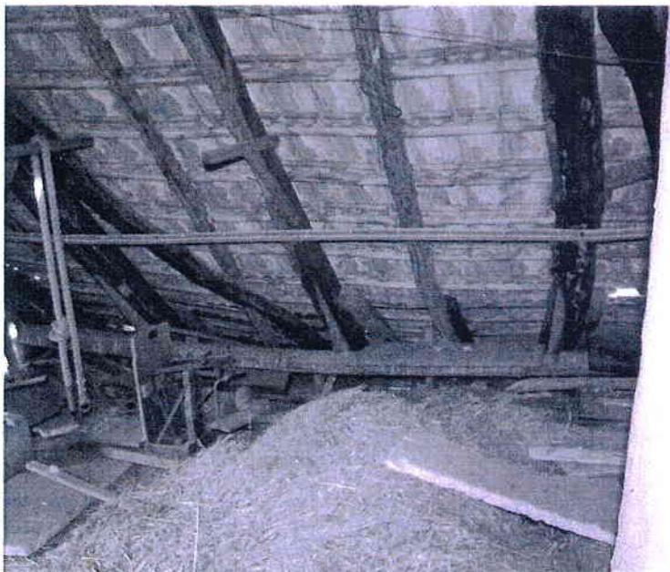
Spitzboden, Nord Betondachsteine, Süd: Hohlziegel in Strohdocken
