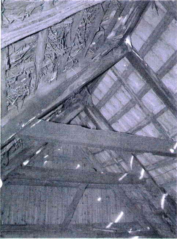
Spitzboden, Nord Betondachsteine, Süd: Hohlziegel in Strohdocken
