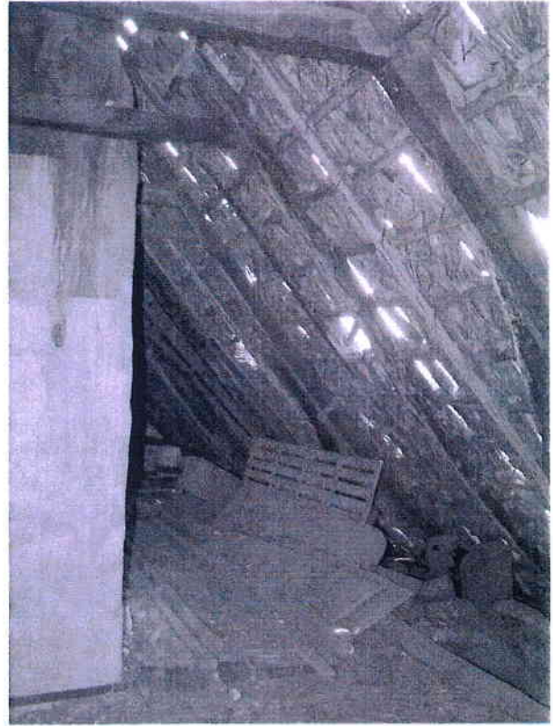
Spitzboden, Nord Betondachsteine, Süd: Hohlziegel in Strohdocken
