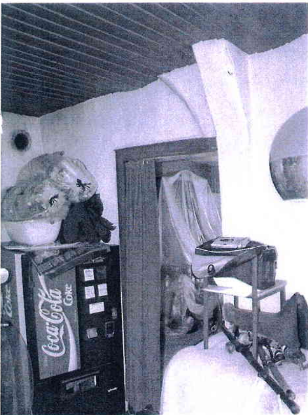
Haupthaus Rübhelhauk 4 in 49626 Berge: ehemalige Wohn-und Schlafräume
